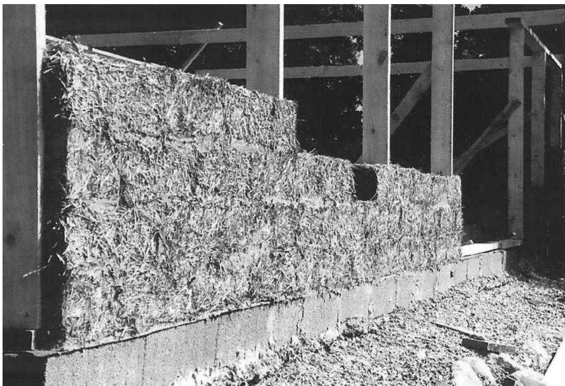
Рис. 10.14. Строительство из известково-соломенных блоков. Источник: [51]
