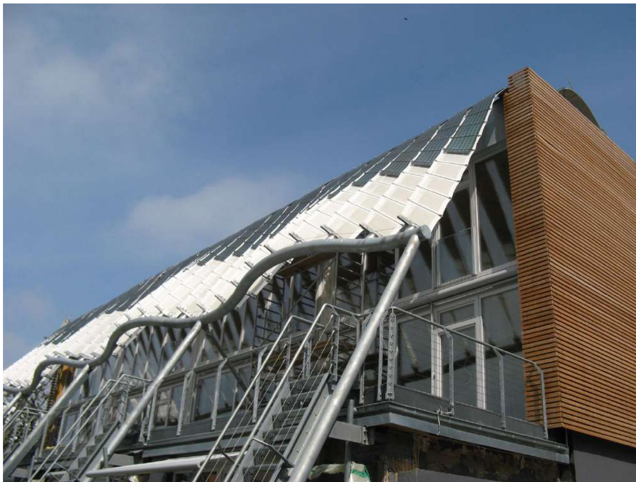
Рис. 10.8. Установка вращающихся вслед за солнцем солнечных коллекторов, Гамбург. Международная строительная выставка. Фото В. Линова
